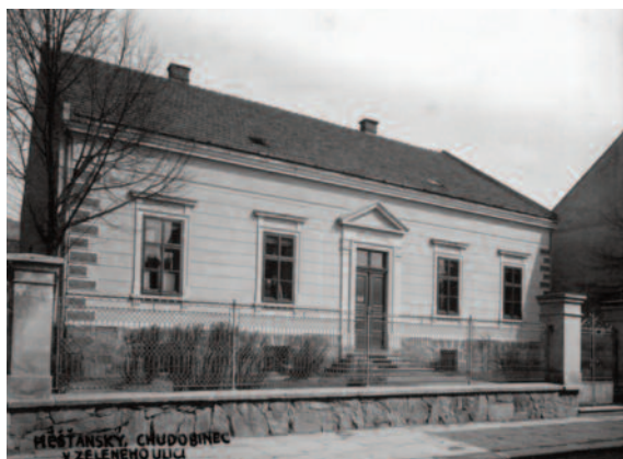
Budova někdejšího měšťanského chudobince v Příčné ulici nyní slouží potřebám mateřské školy
